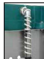
Version chauffante, arrivée d'eau à l'air libre avec un câble chauffant
