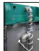
Version chauffante, raccordement à un circuit en boucle avec un câble chauffant
